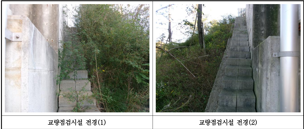
【사진 31.3.25】 교량 점검시설 전경
