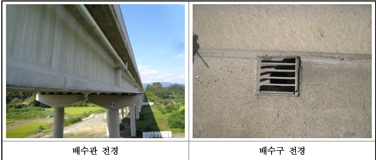
【사진 31.3.21】 배수시설 전경
