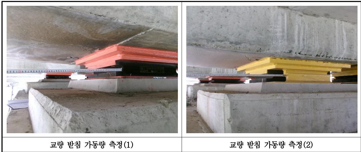
【사진 31.3.40】 교량받침 이동량 측정
