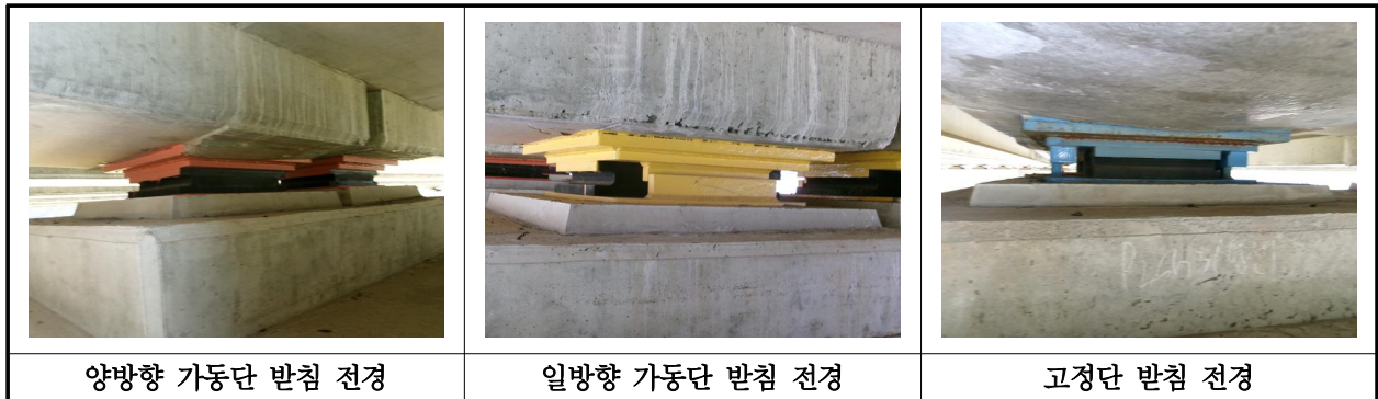
【사진 31.3.37】 교량반침 전경
