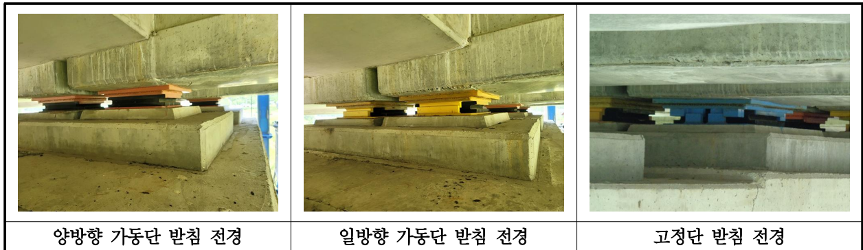
【사진 31.3.12】 교량반침 전경
