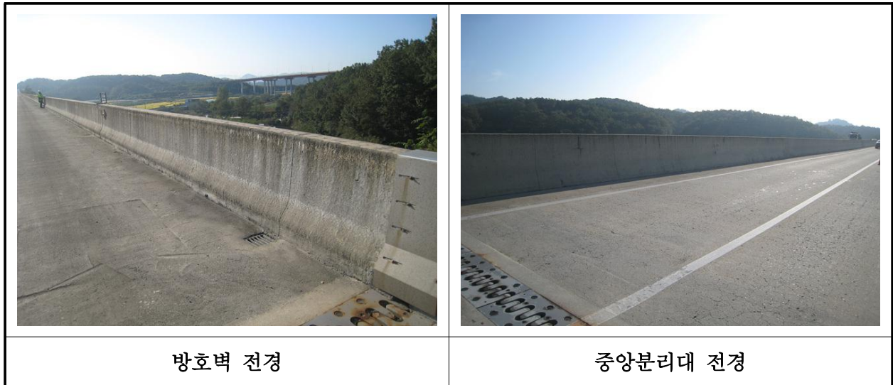
【사진 31.3.48】 방호벽 및 중앙분리대 전경
