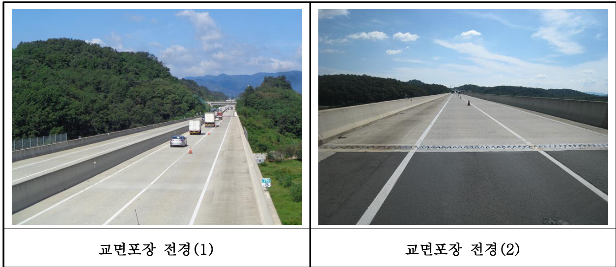
【사진 31.3.19】 교면포장 전경
