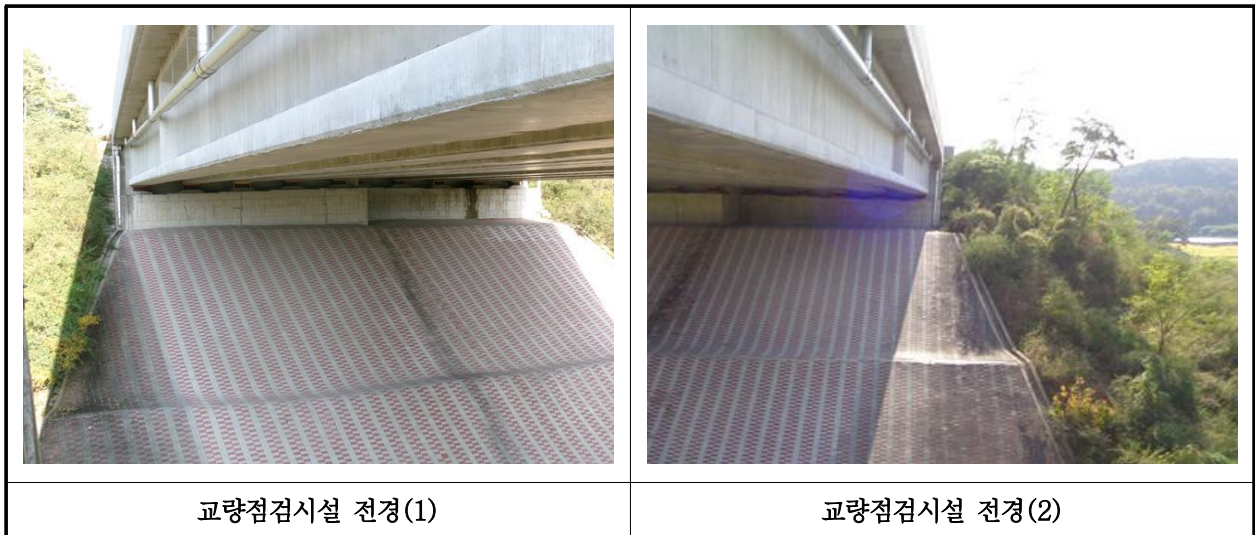
【사진 31.3.50】 교량 점검시설 전경
