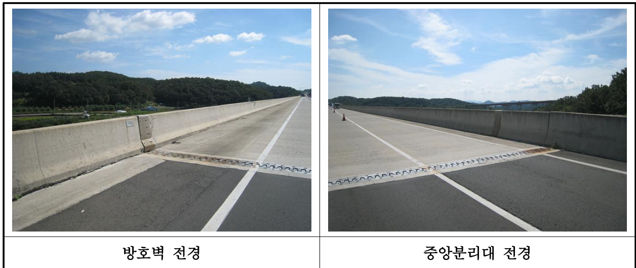
【사진 31.3.23】 방호벽 및 중앙분리대 전경
