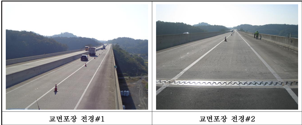
【사진 31.3.44】 교면포장 전경
