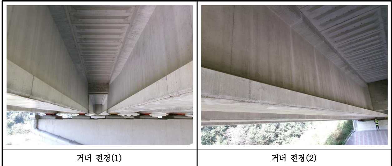
【사진 31.3.29】 거더 전경
