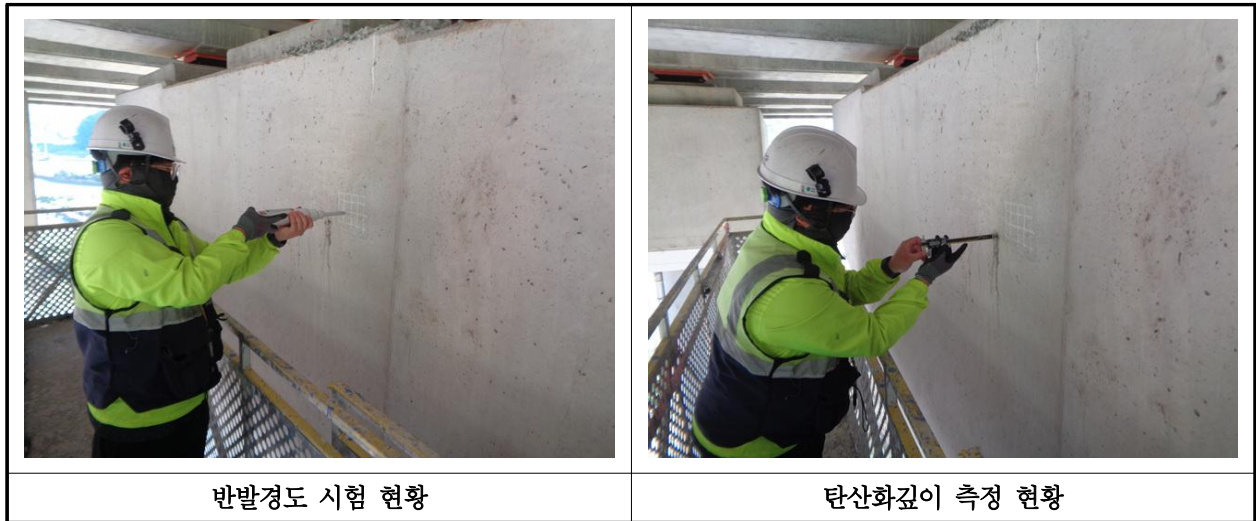
【사진 31.4.1】 콘크리트 내구성조사 현황
