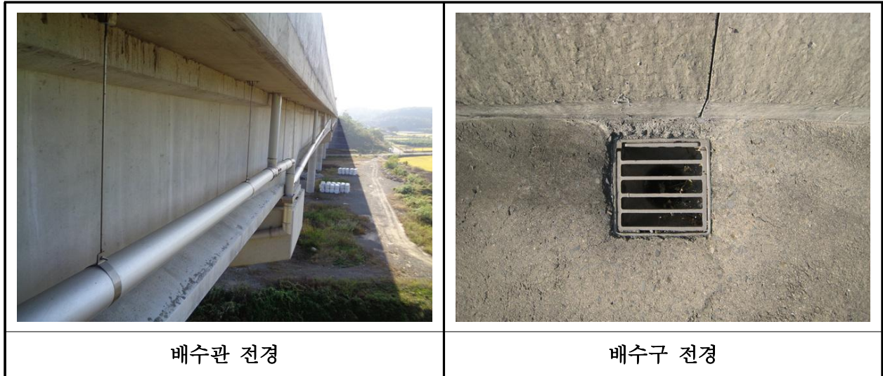
【사진 31.3.46】 배수시설 전경
