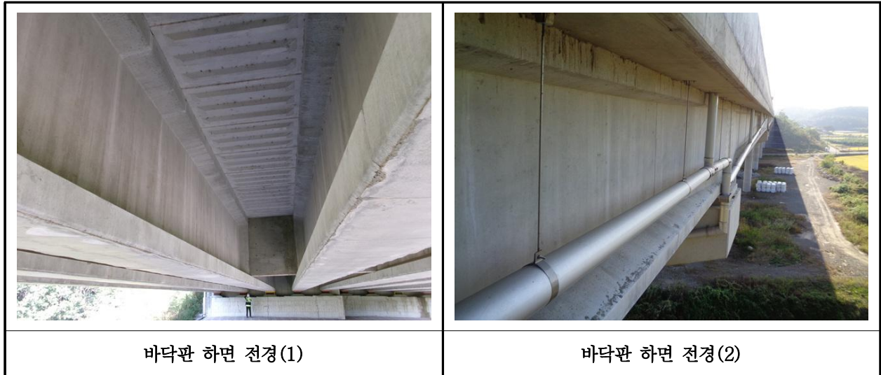
【사진 31.3.27】 바닥판하면 전경
