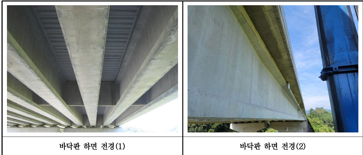
【사진 31.3.2】 바닥판하면 전경
